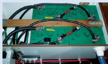
BATTERIER: Et startbatteri og fire 6 volts transaksjonsbatterier til forbruket er en dyr og meget god løsning.
