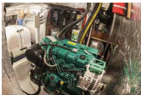
Motorrummet ligger akter om navigeringsstationen på babord sida. Det är en fröjd för ögat och väldigt tillgängligt vid behov.
